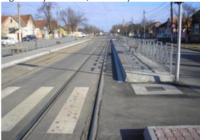
Fig.15. Stație tramvai, str. Renașterii
