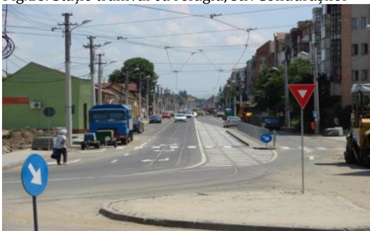
Fig.16. Stație tramvai cu refugiu, str. Condurașilor
