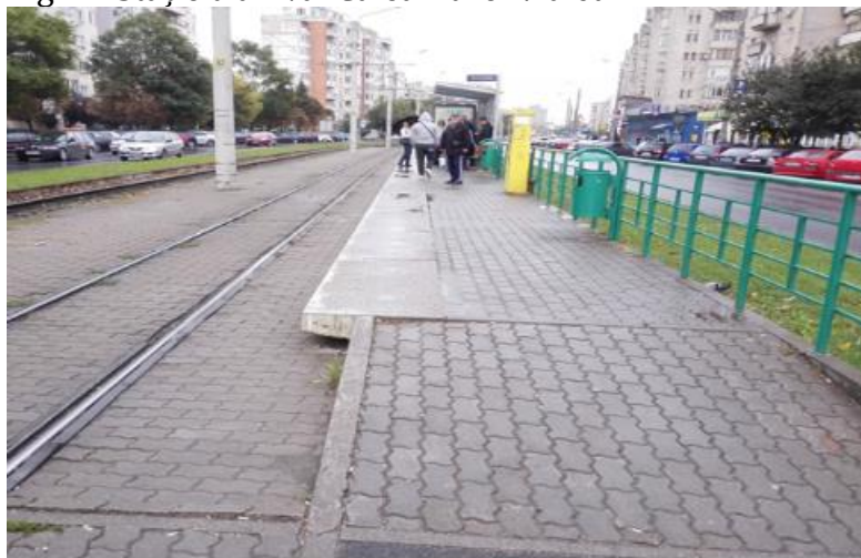
Fig.17. Stație tramvai Calea Aurel Vlaicu
